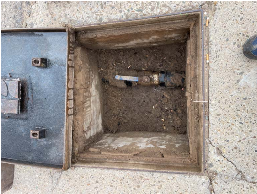
Fotografía nº2.- Nudo 2, con llave no operativa que fuga. Se va a cambiar la llave por una nueva.
